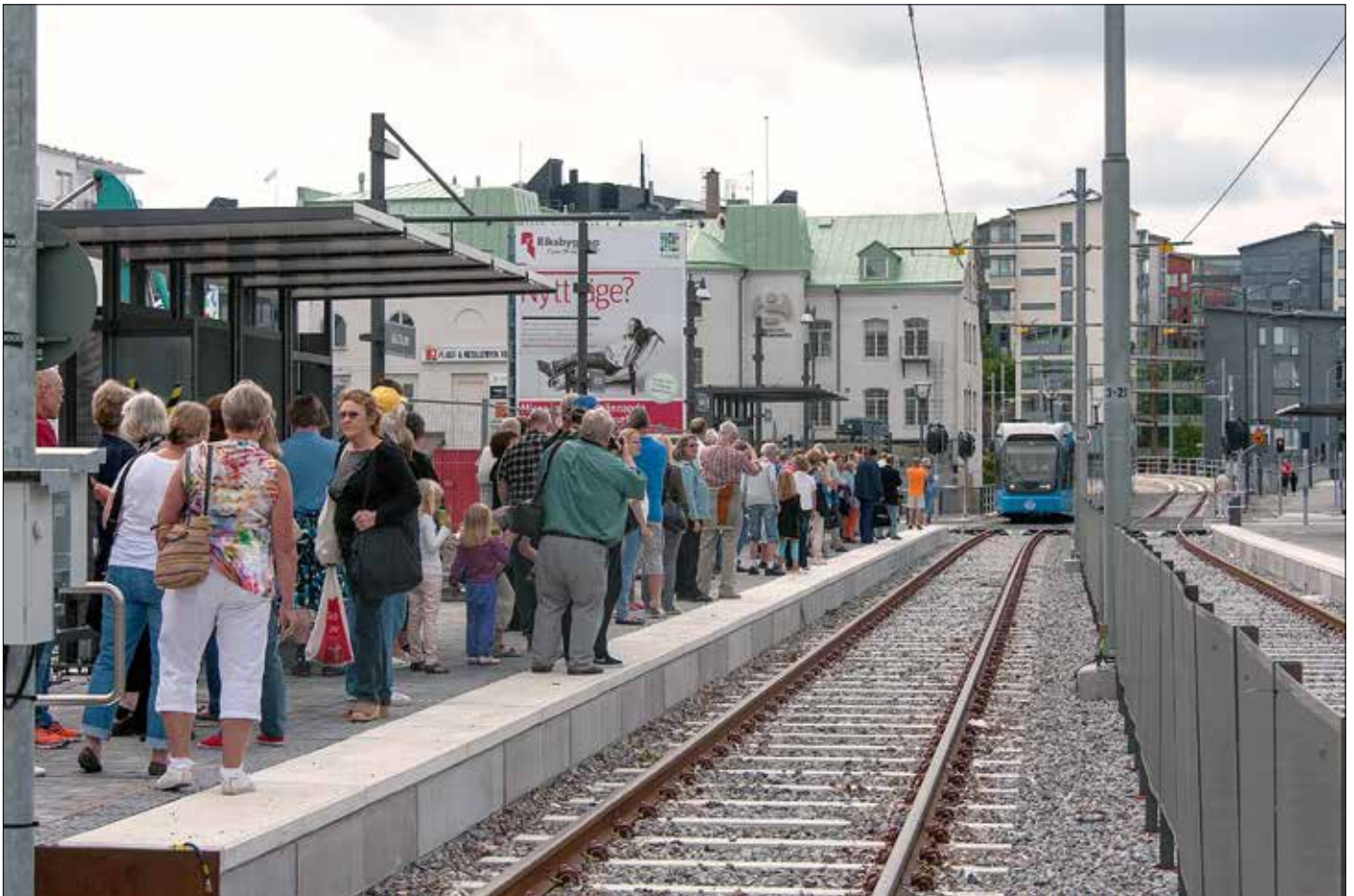
Hållplats vid Tvärbanan i Stockholm. Gott om staket, barriärer, ballastspår med vignolräl och korta väderskydd i båda färdriktningarna.
