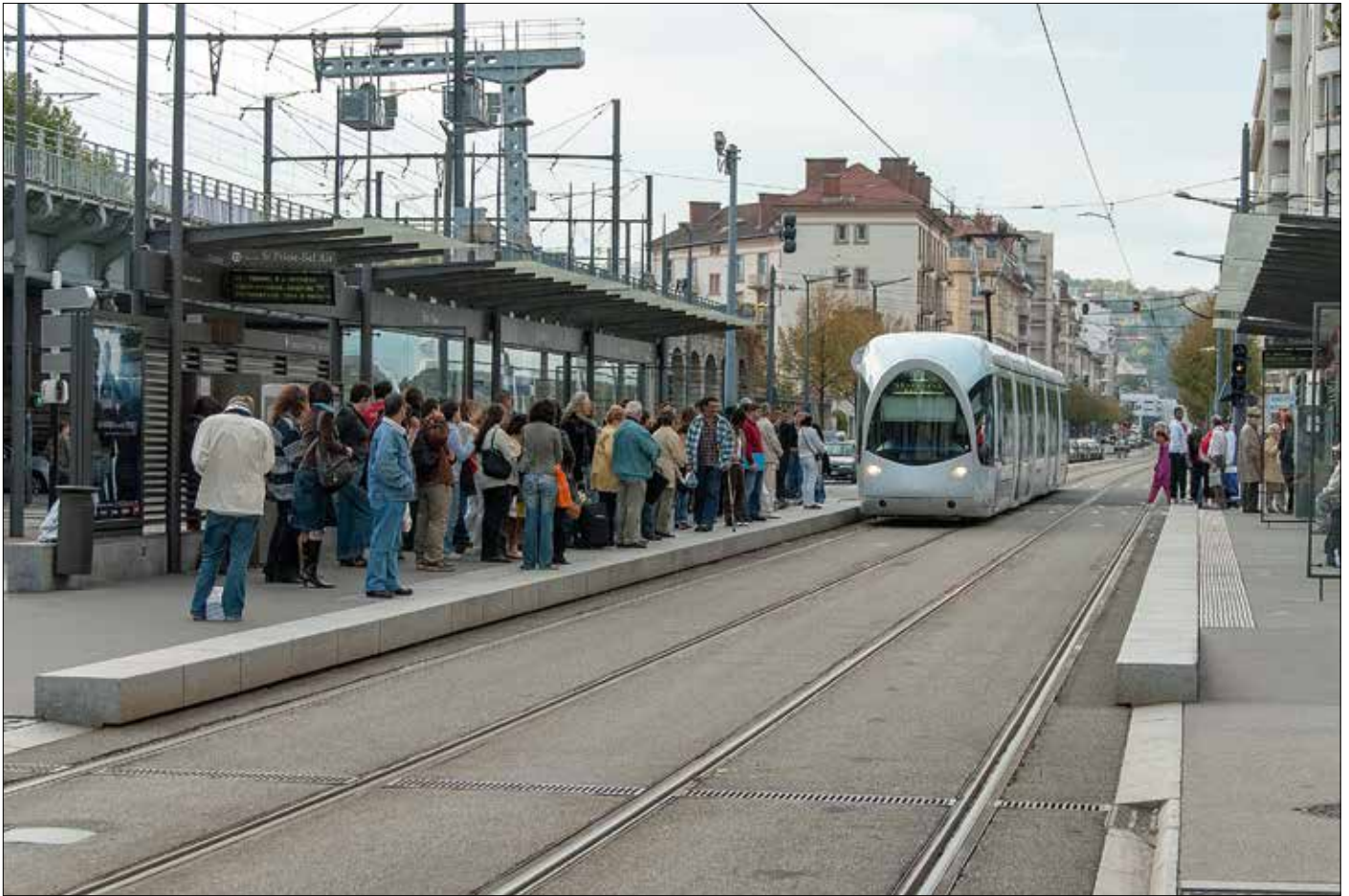
Hållplats vid spårvägen i Lyon. Öppna ytor, inga staket, inga barriärer, hårdgjord spåryta och långa väderskydd i båda färdriktningarna.
