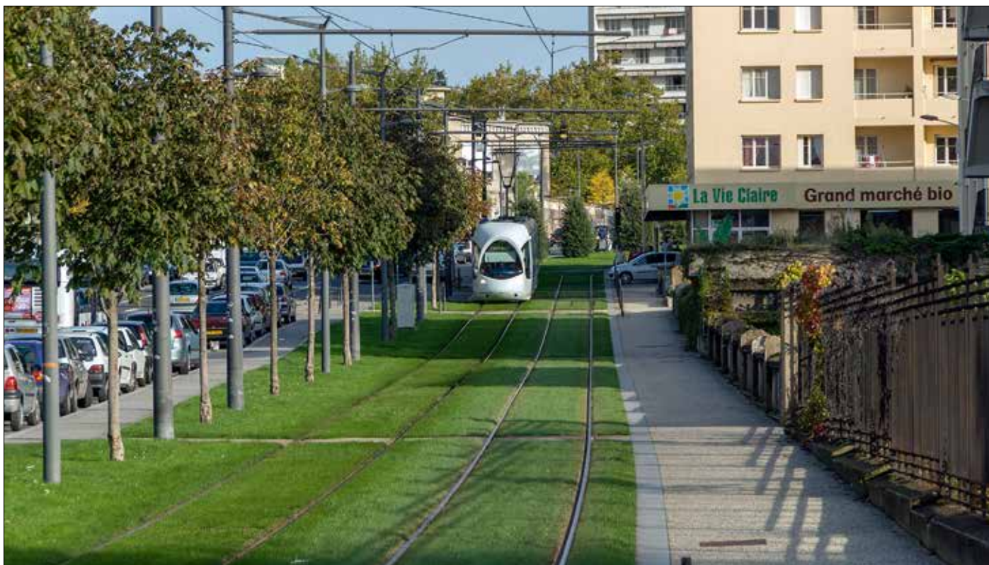
Ny spårväg i stadslandskapet, exempel från Lyon. Barriäreffekt närmast obefintlig, dock framgår tydligt vilken del av gatuutrymmet som spårvägen utnyttjar. Längre bort i fonden kan ett kort staket anas – vid en kritisk passage med dålig sikt.
